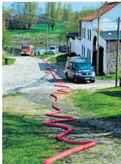
Um an Wasser zu kommen, musste eine Leitung zur Saale gelegt werden.
